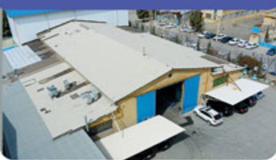
سایت تولید و مونتاژ مبدل های حرارتی Plate heat exchanger production and assembly
