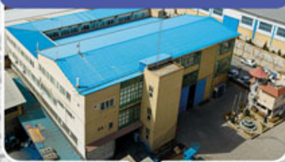
سایت مرکزی و مهندسی Headquarter and engineering office
